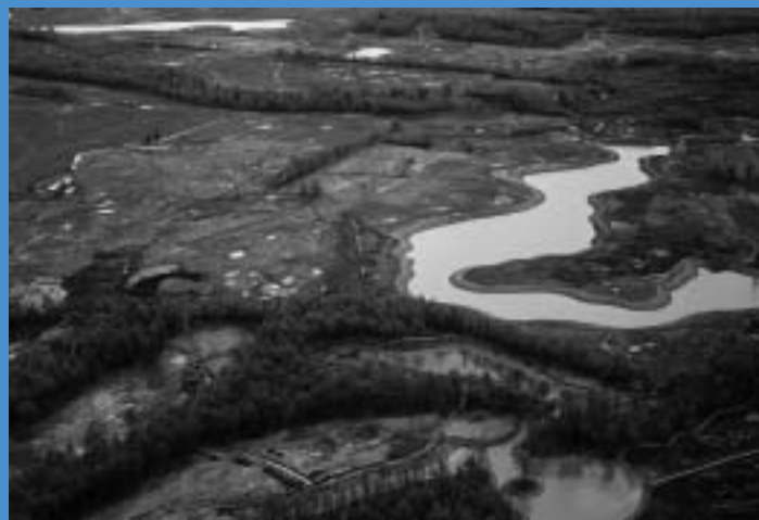
Vue d'ensemble du terrain Ruisseau de Ussher en construction.
