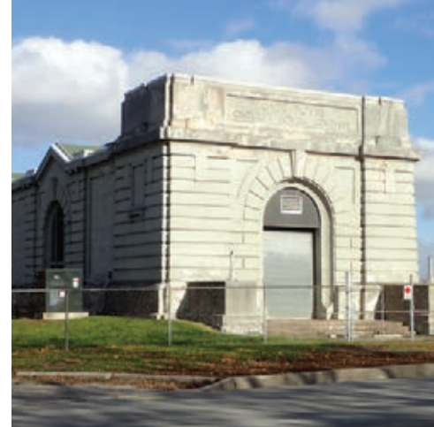
OPGS Gate House
