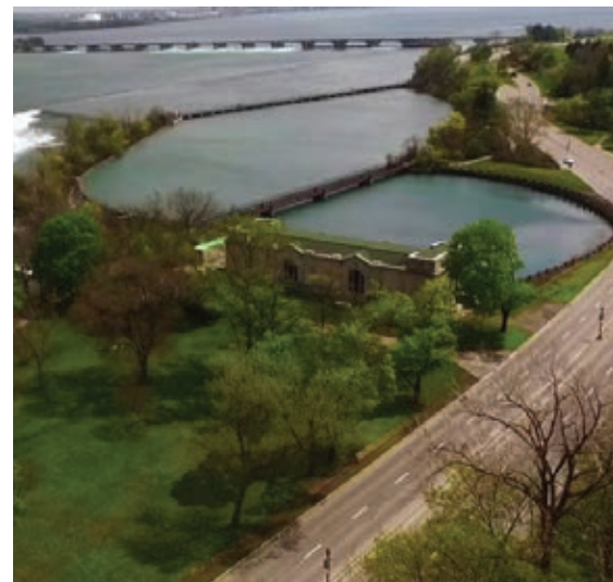
OPGS Gate House
