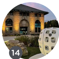
14 Centrale Électriques de Niagara Parks + Tunnel
